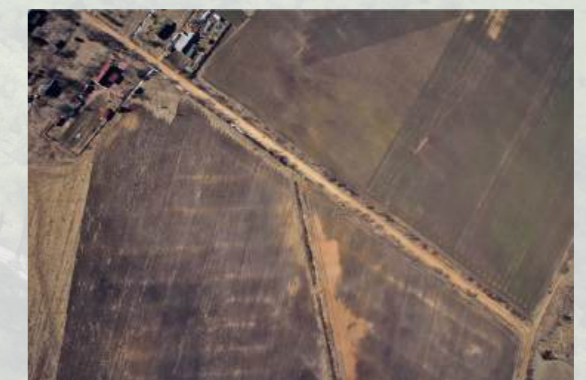
Рис. 4. Идентификация неисправностей закрытого трубчатого дренажа по данным аэрофотосъёмки с беспилотного воздушного судна
